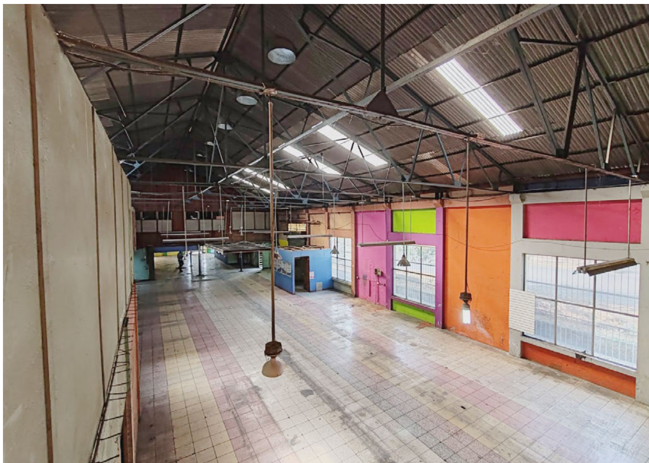
Fotografía interior de la nave principal. Se observan los pisos de terrazo, las cerchas metálicas originales del edificio y las paredes que han sido pintadas varias veces a través de los años por el anterior inquilino.
