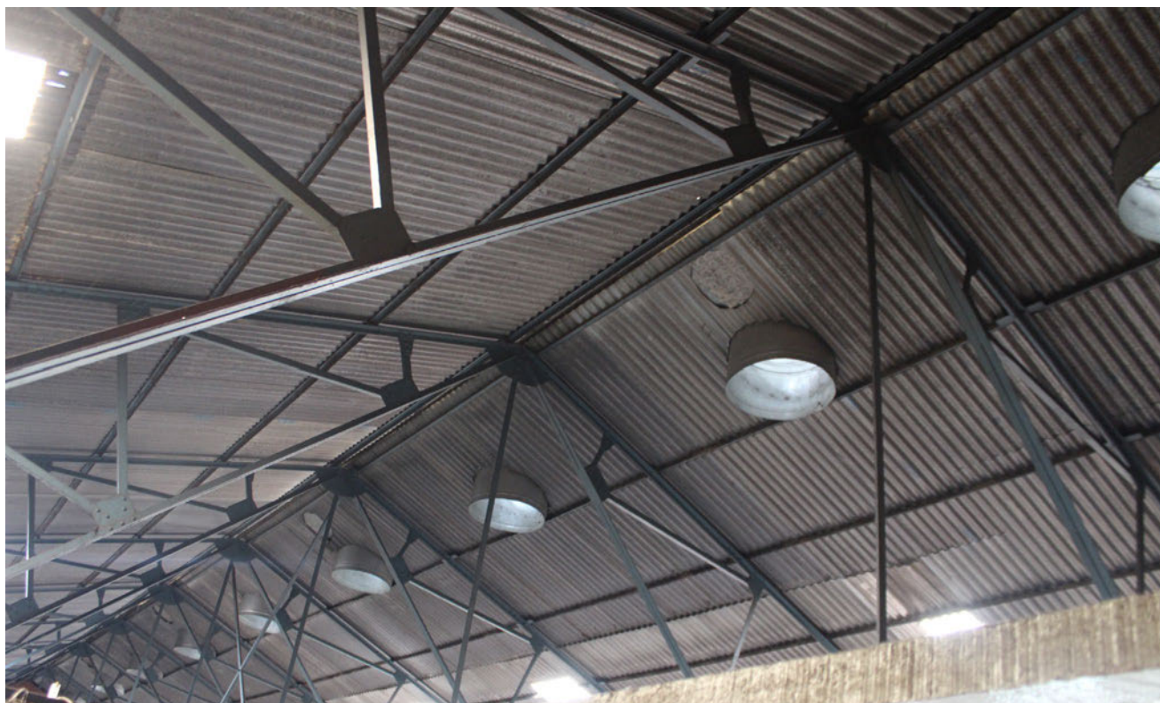
Fotografía interior de la nave principal. Se observan las cerchas de angulares metálicos originales del edificio, y la cubierta de HG ondulado sin pintar, así como las aberturas para la salida de aire por las chimeneas de ventilación instaladas en la parte exterior de las cubiertas.
