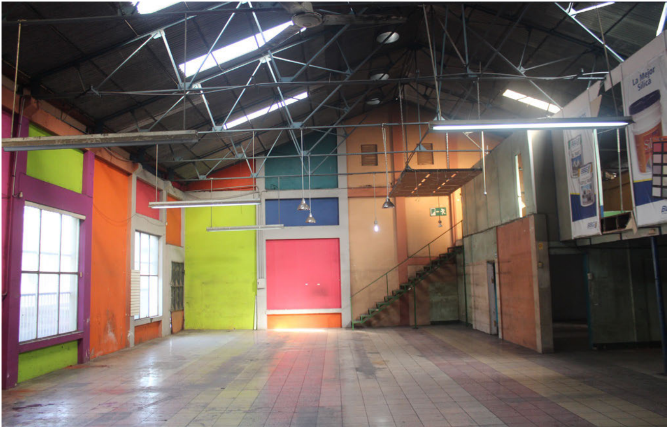
Fotografía del interior de la nave principal, se observa a la derecha el mezaninne construido por el anterior inquilino, hecho de materiales livianos con entepiso de madera, fibrocemento y columnas metálicas, al fondo la escalera metálica usada para subir a este espacio.
