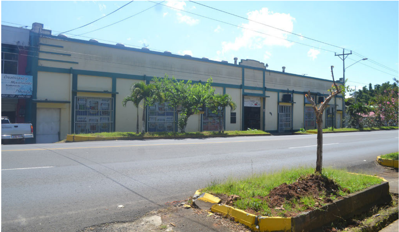
Fotografía de la fachada principal: se observan las 6 ventanas y 3 puertas, además de los elementos decorativos en el tapichal de concreto, elementos que algunos califican de inspirarse en el estilo Art- Decó, aunque en realidad el edificio es de estilo industrial.
