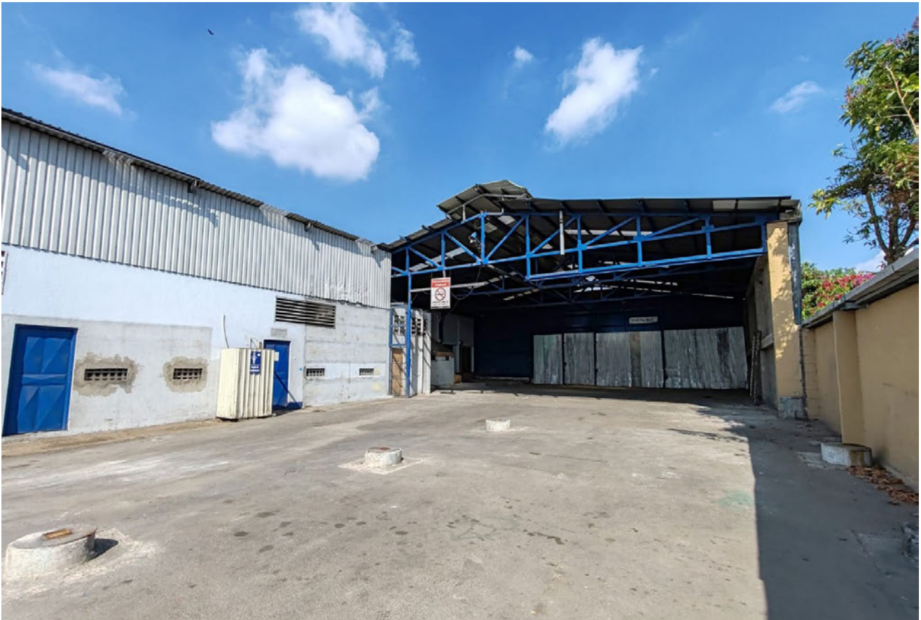
Fotografía de la bodega ubicada en la parte posterior. La bodega fue construida por el anterior inquilino con cerchas metálicas y paredes con lámina estructural, la “bodega azul” como se le conocía da sombra y protege de los elementos a los antiguos hornos de tabaco.
