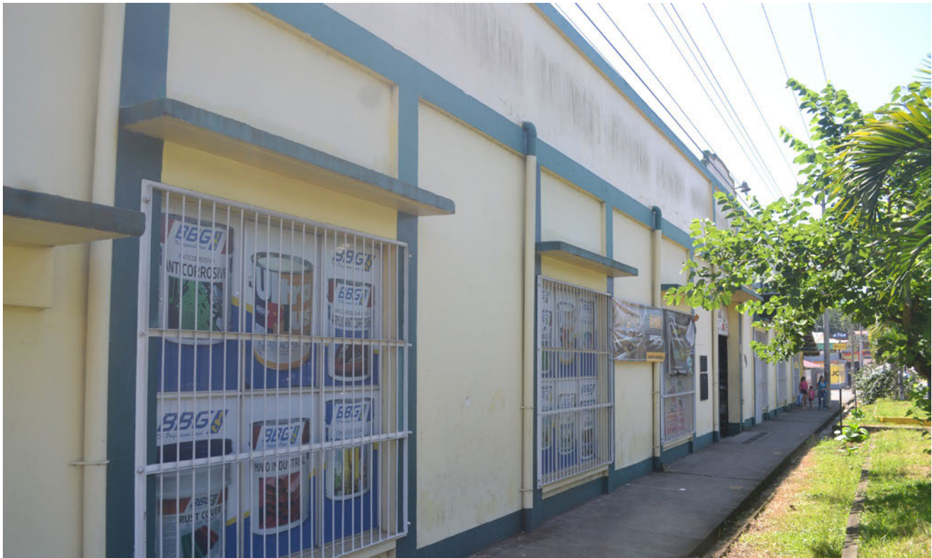
Fotografía de la fachada principal: se observan las marquesinas sobre las ventanas y puertas, además de la altura del edificio, cuando vemos la escala humana al fondo. Las verjas en las ventanas no son originales del edificio, pero deben conservarse por seguridad.
