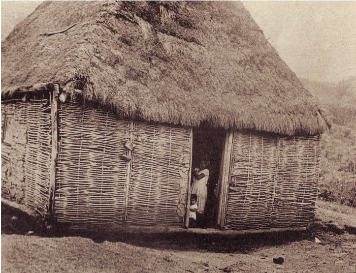
5b. Tronco único como base de la casa (nótese ventana a la izquierda, y levadura para la chicha colgando en la pared del frente).
