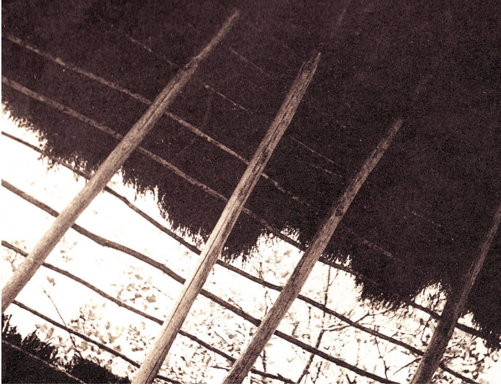
6c. Armazón del techo en etapa posterior, Boruca.
