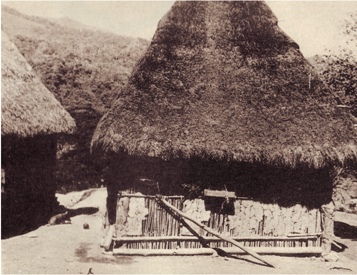
4c. Construcción de varas verticales con partes de bajareque ; “nido” colgante para gallina
