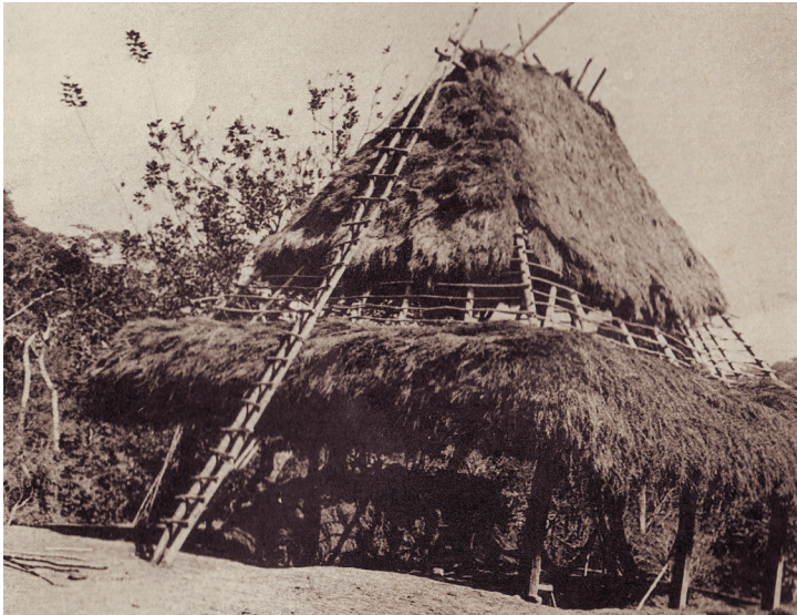
6d. Techo parcialmente terminado muestra armazón, zacate y escalera.
