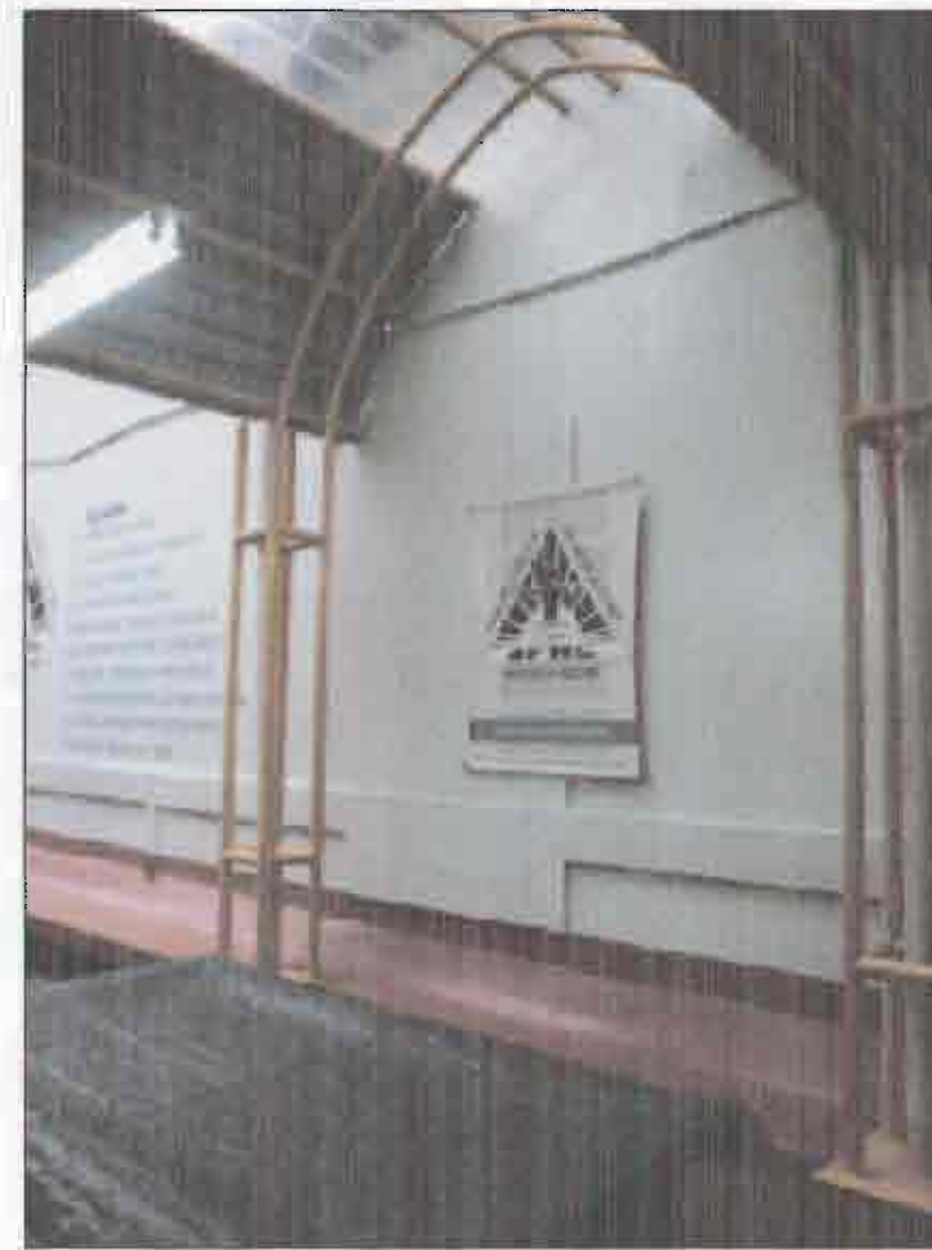
DETALLE DE CUBIERTAS EN FORMA DE ARCO CON SECCION CIRCULAR EN METAL, ES UNA DE LAS SECCIONES CONSTRUIDAS MAS RECIENTEMENTE
