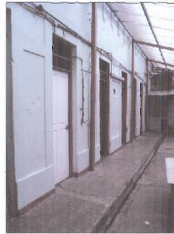
PUERTA ESTANDAR, ELABORADA EN MADERA, CON VENTANA EN LA PARTE SUPERIOR CON LAMINA METALICA NO ORIGINAL, NECESITA REPARACION EN EL MARCO
