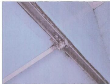
DETALLE DE JUNTA DE RIELES ESTRUCTURALES EN PAREDES, VERTICALES CON HORIZONTALES, LOS VERTICALES SE ENCUENTRAN CON UNA PROPORCION DE 80x60 CADA UNA
