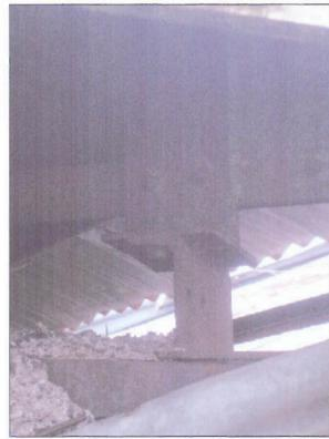
DETALLE DE JUNTA DE ESQUINA DE CERCHA DEL TORRION CON LA PARED, SECCIONES METALICAS ATORNILLANDO LAS CERCHAS AL CONCRETO
