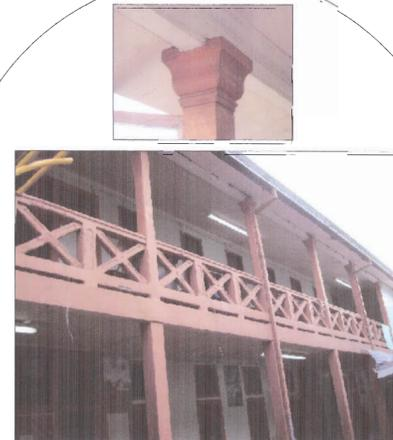
DETALLE DE BARANDA DE CONCRETO ORIGINAL, CON UN GRADO DE DETERIORO BAJO, SE RECOMIENDA UNA RESTAURACION LEVE
