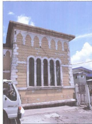
VENTANA ORIGINAL, ELABORADA EN CONCRETO CON REJILLA METALICA, CON BORDE SUPERIOR EN FORMA CIRCULAR, CON UN NIVEL DE DETERIORO BAJO, SE RECOMIENDA UNA RESTAURACION LEVE
