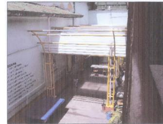
DETALLE DE CUBIERTAS EN FORMA DE ARCO CON SECCION CIRCULAR EN METAL, ES UNA DE LAS SECCIONES CONSTRUIDAS MAS RECIENTEMENTE
