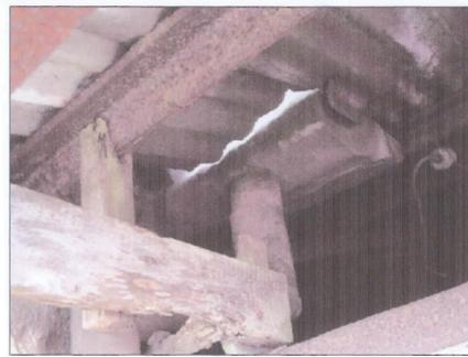
DETALLE DE ANCLAJE DE LOS CLAVOS AL ANGULAR DEL CLAVADOR
