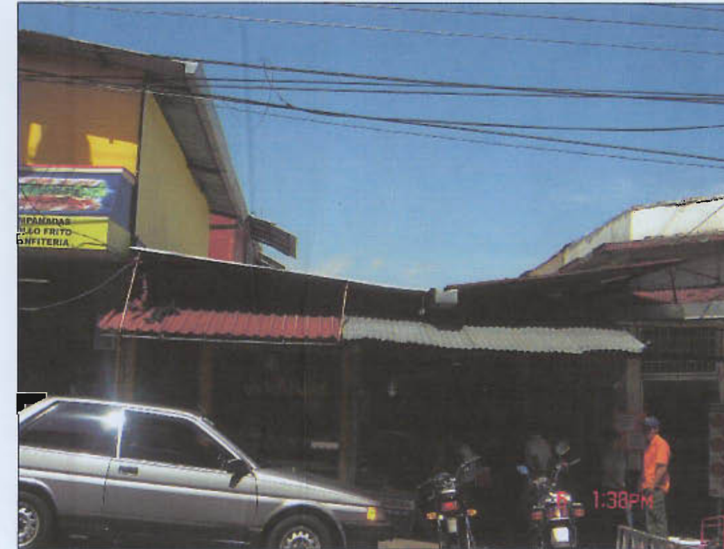
VISTA COSTADO OESTE
