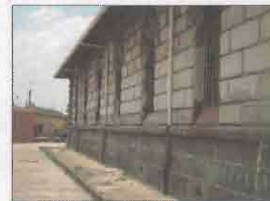
VISTA TOTAL DE LA FACHADA NORTE
