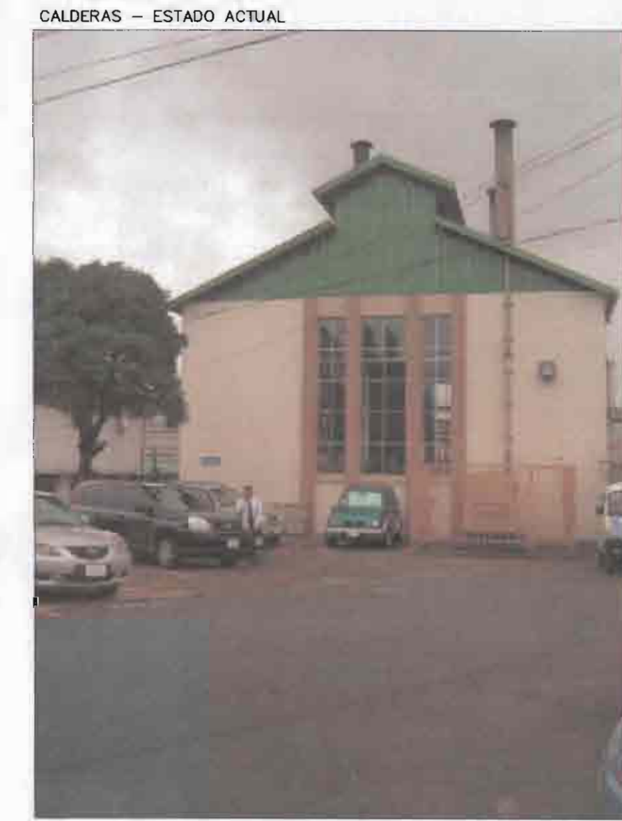
CALDERAS - ESTADO ACTUAL
