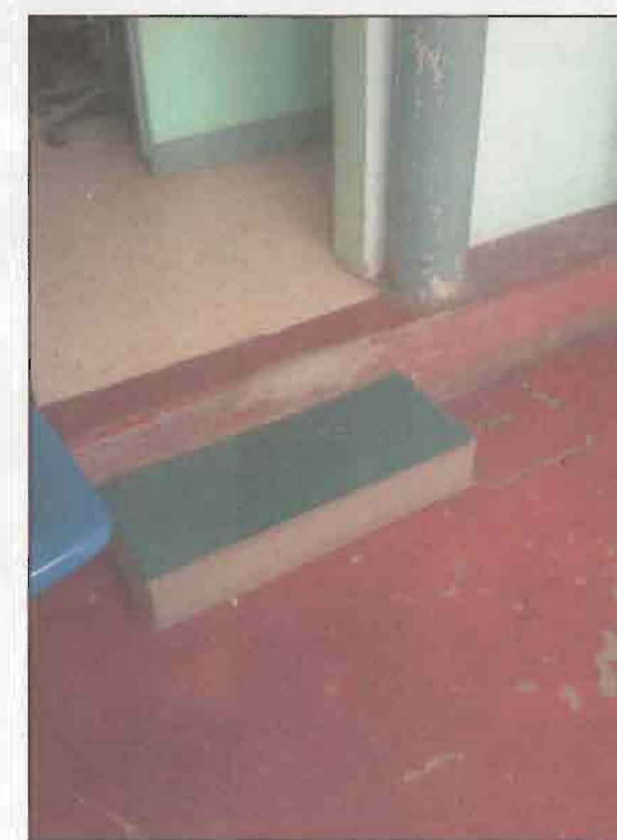
FOTOGRAFÍAS DEL AREA A INTERVENIR
