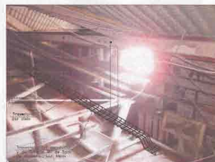
TRAYECTORIA DEL DUCTO-CIELO FIBRA OPTICA SIN ESCALA
