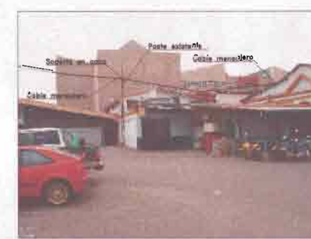
TRAYECTORIA DEL DUCTO-POSTERIA FIBRA OPTICA SIN ESCALA
