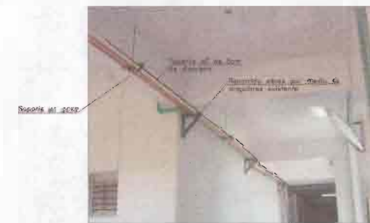
TRAYECTORIA DEL DUCTO-ANGULARES FIBRA OPTICA SIN ESCALA
