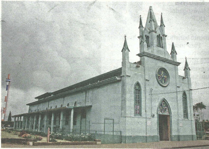
Las filtraciones de agua y el comején han deteriorado la estructura de madera forrada con metal. ARCHIVO.
