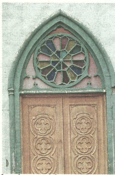
Las filtraciones de agua y el comején han deteriorado la estructura de madera forrada con metal. ARCHIVO.
