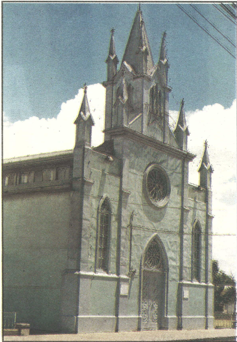
La propuesta del arquitecto Carlos Araya Aguilar para reparar el templo católico Nuestra Señora María Auxiliadora de Cartago fue la ganadora del Certamen "Salvemos Nuestro Patrimonio Histórico y Arquitectónico".
