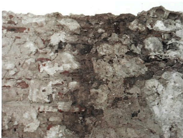
Figura 33. Detalle de la pared Oeste con relleno caótico entre las rocas
