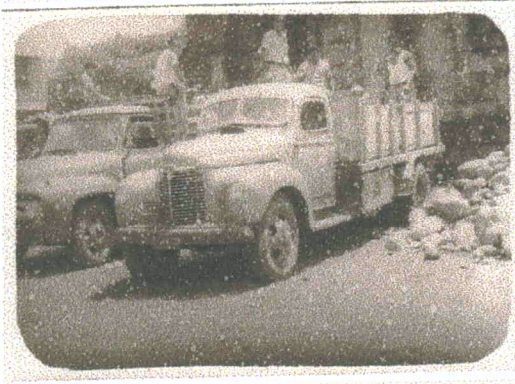
TRABAJOS EN EL TEMPLO, 1950-1960
