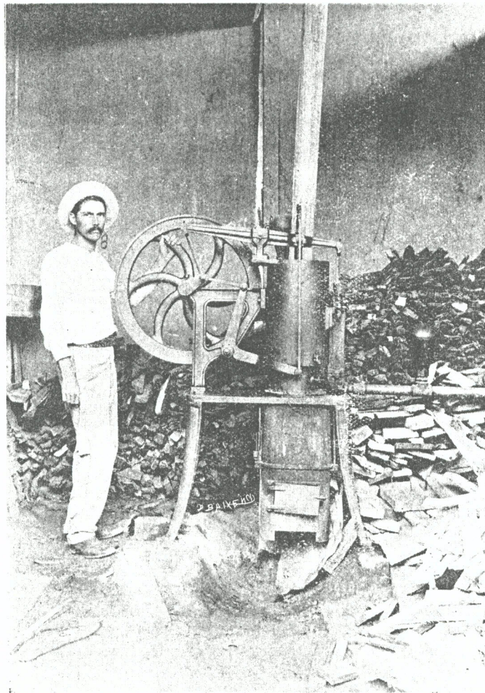
Puntarenas. Bomba de aire caliente de los baños, cárcel y cuartel
