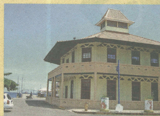
La Capitanía del Puerto es una edificación de valor patrimonial. Rolando Avilés.
