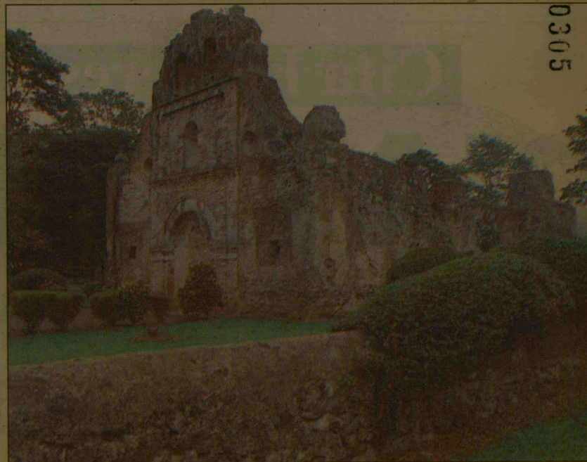
El templo de Ujarrás fue construido en 1666 y hoy sus ruinas están en peligro por el socavamiento del río Reventazón.
