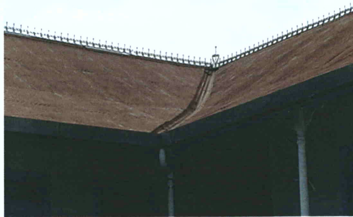
Techos de láminas de HG galvanizado, vigas y columnas de madera.
