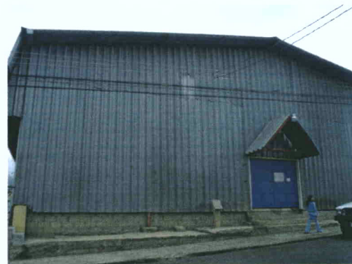
Recubrimiento del Gimnasio de láminas de zinc
