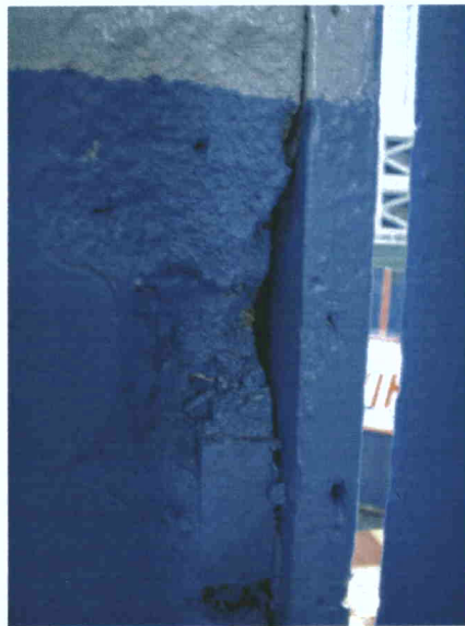
Bahareque Francés utilizado para su construcción
