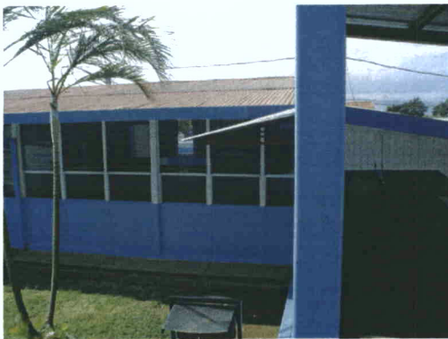
Aulas hechas con elementos Prefabricados
