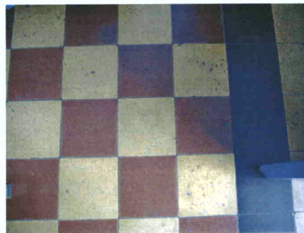
Piso de la escuela José Martí
