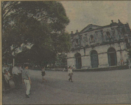
La construcción ha resistido el paso del tiempo gracias a sus gruesas paredes construidas con piedra viva.
