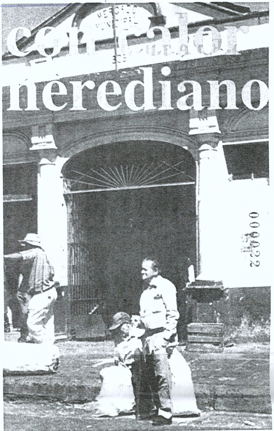
Remodelaciones, agregados y demás poco a poco han ido aniquilado su fachada original.
