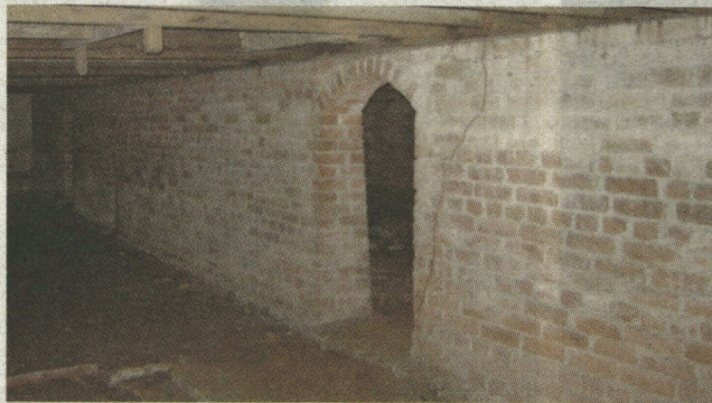
La red de túneles de Heredia fue construida por Fadrique Gutiérrez en 1874. ARCHIVO
