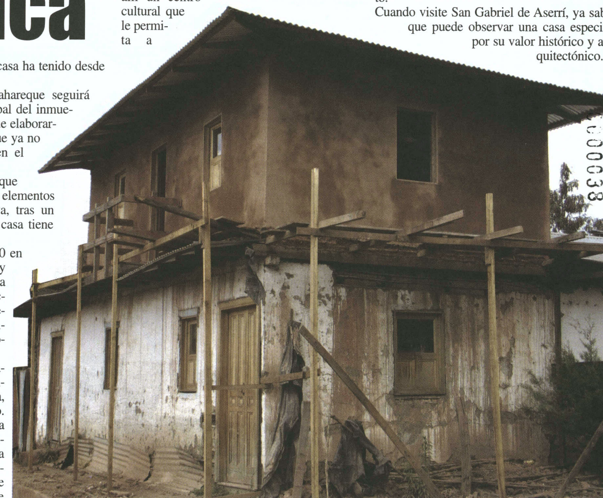
La renovación de estructuras permitirá que la única casa de bahareque de dos pisos en Costa Rica soporte sismos y otros eventos.
