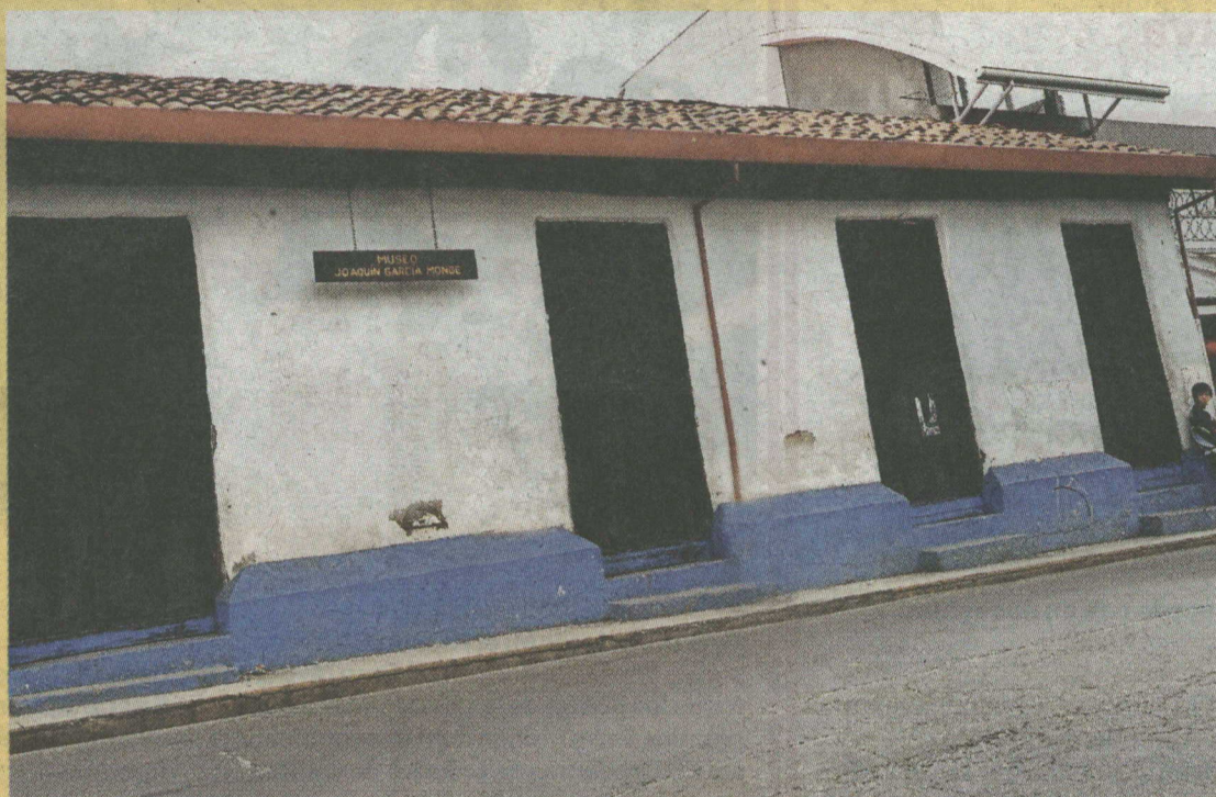
La casa está hecha de adobe y su techo es de teja. » HERBERT ARLEY.
