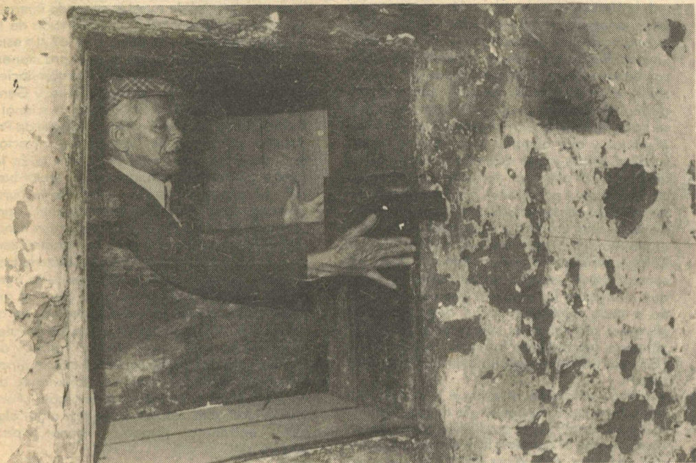
La centenaria casa está en estado ruinoso, pero ADECAS ya gestionó el dinero para arreglarla. (Montenegro)
