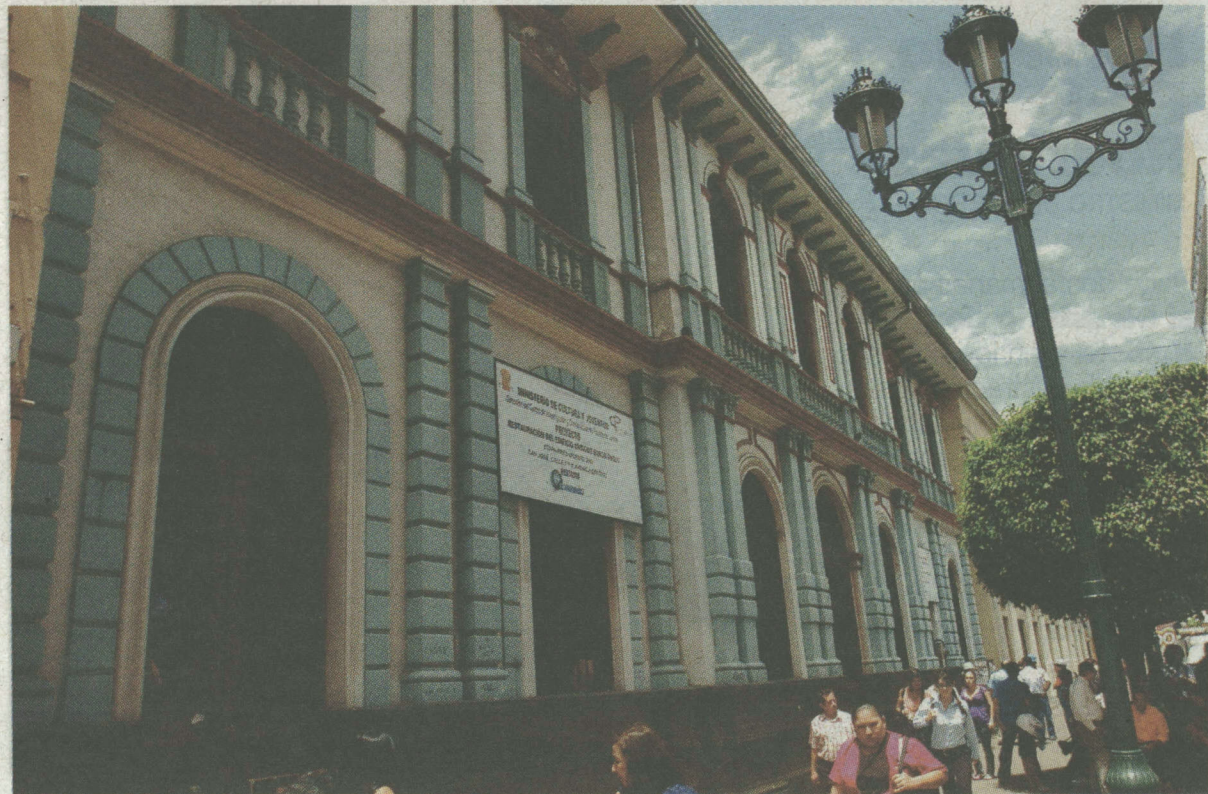
La primera sede del Banco Anglo Costarricense forma parte de un conjunto urbano histórico, con el edificio Knöhr (a su derecha), el Gran Hotel Costa Rica (a su izquierda) y la Librería Lehman (al frente). ALONSO TENORIO
