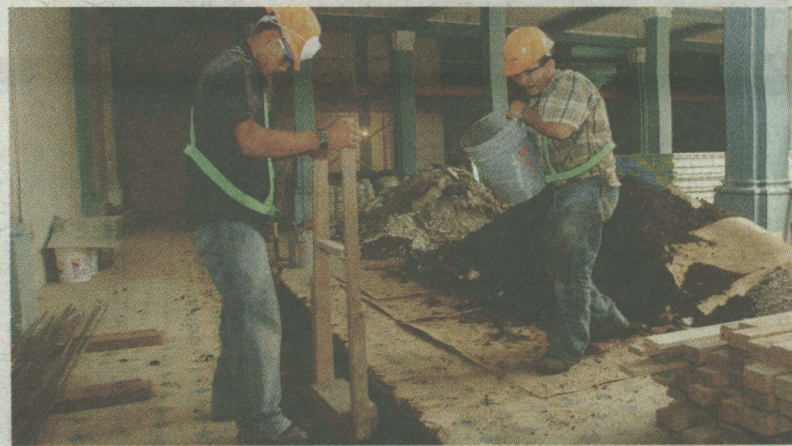
En el primer piso, las tuberías de electricidad se están instalando bajo el suelo. Los mosaicos originales se colocarán después. ALONSO TENORIO
