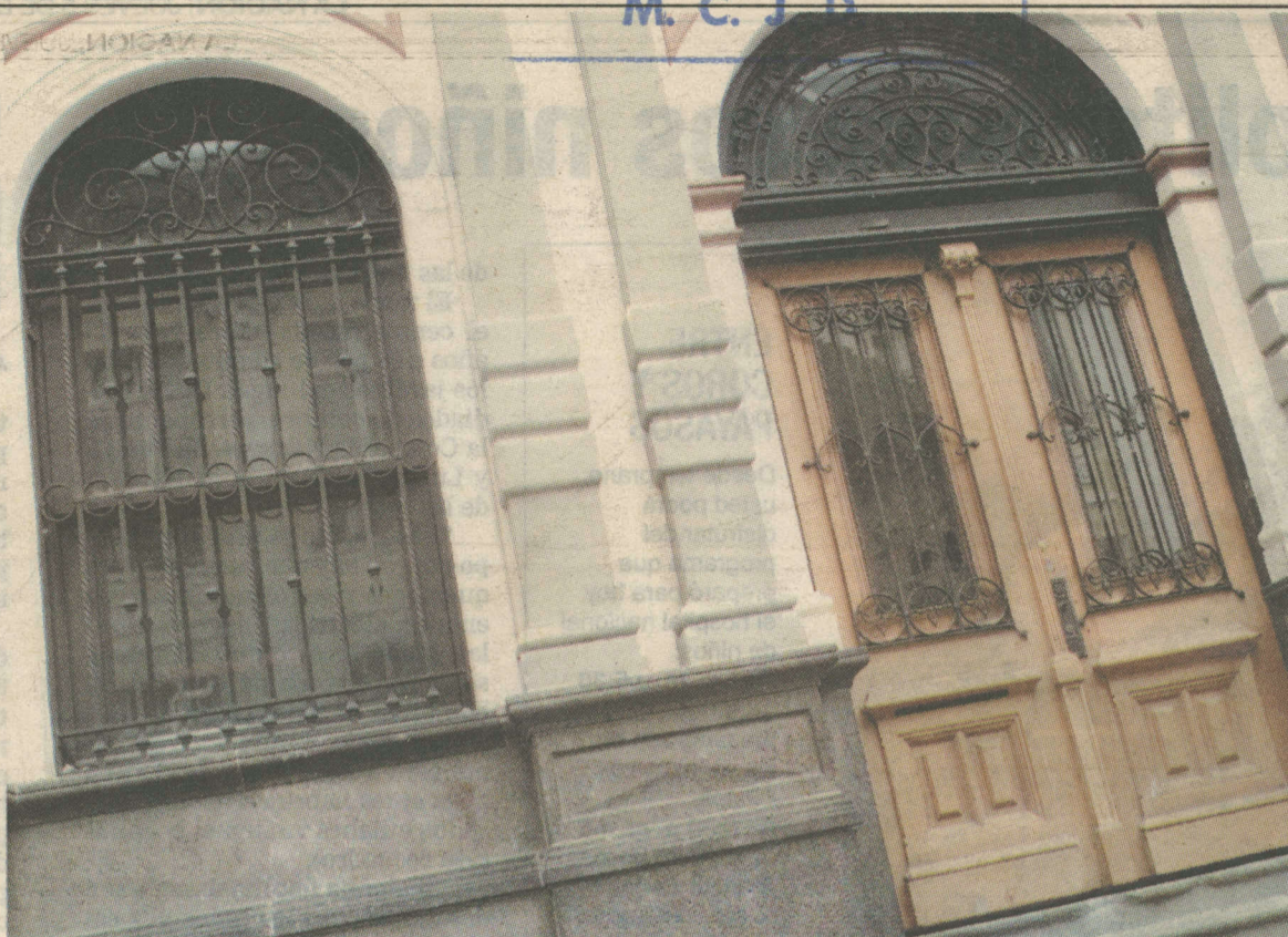
El edificio Knohr está en restauración, bajo la supervisión del Centro de Patrimonio del Ministerio de Cultura.
