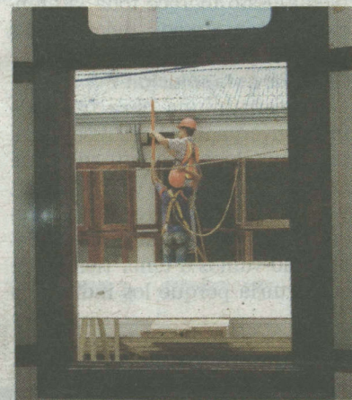
Reparación de los marcos de ventanas y puertas. ALONSO TENORIO
