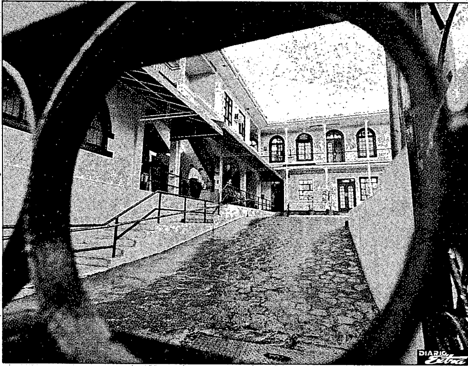
El Edificio Sión carece de numerosos requisitos para continuar abierto, según el Ministerio de Salud Pública.
